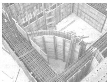
1 9/22教學大樓地下室地樑模板組立完成
