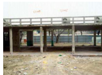
3.露德樓穿堂打除工程施工完成照片
