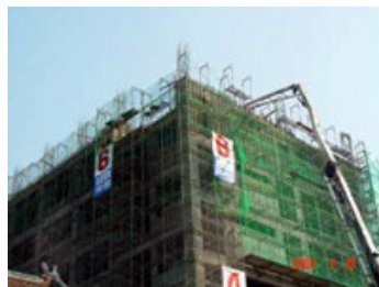
2.教學大樓8FL樓版混凝土澆築作業照片
