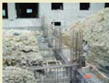
3.露德樓穿堂後方銜接走廊基礎鋼筋 綁紮施工照片
