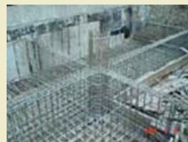
4.文化走廊基礎鋼筋綁紮施工照片
