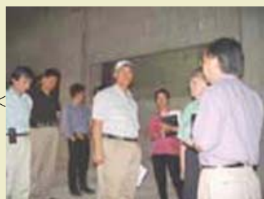
1.93.3.17李校長率日後使用單位主管視 導教學大樓工地
