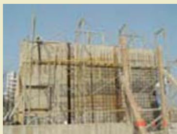
2.研究及會議大樓基礎開挖鋼板樁打 設施工照片
