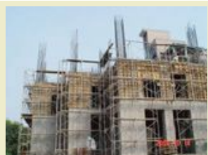
1. 研究及會議大樓3F鋼筋綁紮工程施工照片
