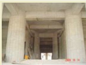
3. 研究及會議大樓1F入口門廳結構體完成照片
