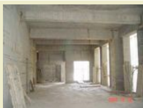
2. 研究及會議大樓1F校史室結構體完成照片
