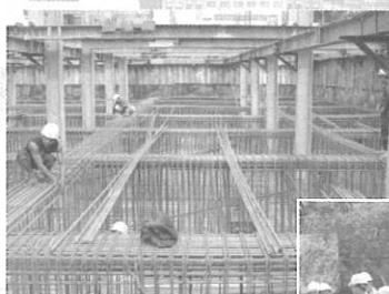
4 9/17教學大樓地下室工程地樑鋼筋綁紮施工照片
