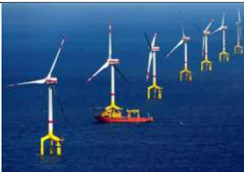
台德未來在能源再生議題深化合作的空間很大 （圖為離岸風電設施）
