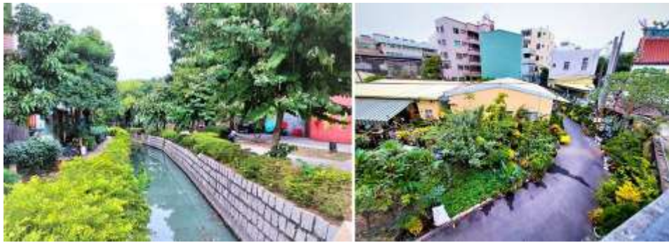
位於曹公廟旁的曹公排水渠，以及從城牆「平成砲臺」上眺望的護城河暗溝。
