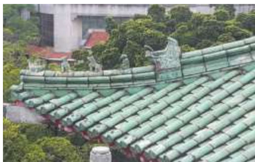
正氣樓西側屋瓦之仙人走獸
