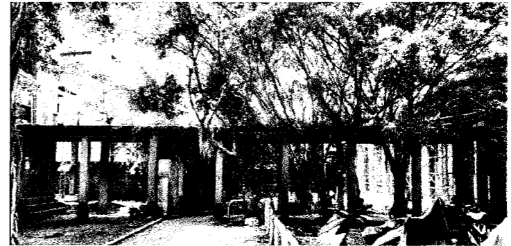
台大昆蟲館2017年指定為直轄市定古蹟，北市文化局決議擴大古蹟範圍，將通廊納入昆蟲館附屬設施。
