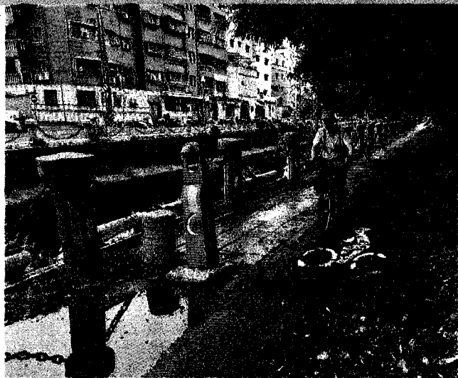
↑ 大排道路規劃為自行車道，護欄鐵鍊旁就是深約二樓高的大排。對機車來說危險，騎自行車應該不算安全。
